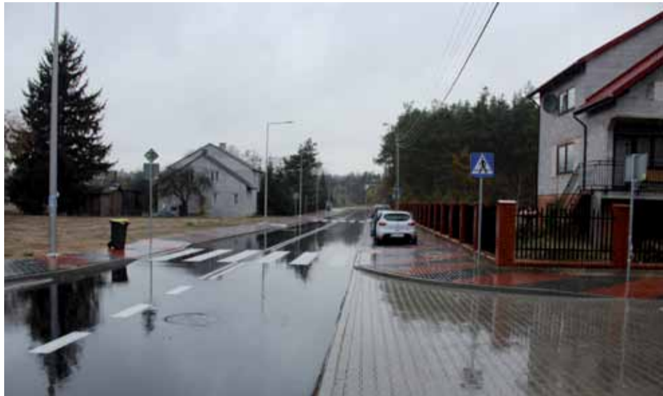
Wyremontowana ulica Akacja
