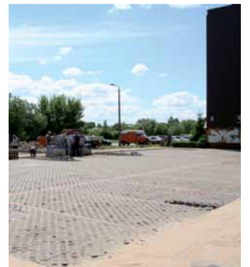
Budowa osiedlowych parkingów jest koniecznością
