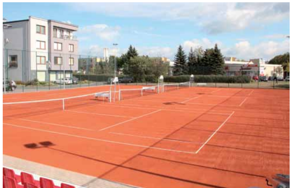
325 tys. złotych dofinansowania ze środków rządowych trafiło na przebudowę kortów tenisowych przy ul. Hallera
