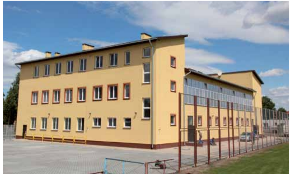
50% środków finansowych uzyskało Miasto na modernizację i przebudowę domu sportowca ( hali sportowej w Wojciechowicach)
