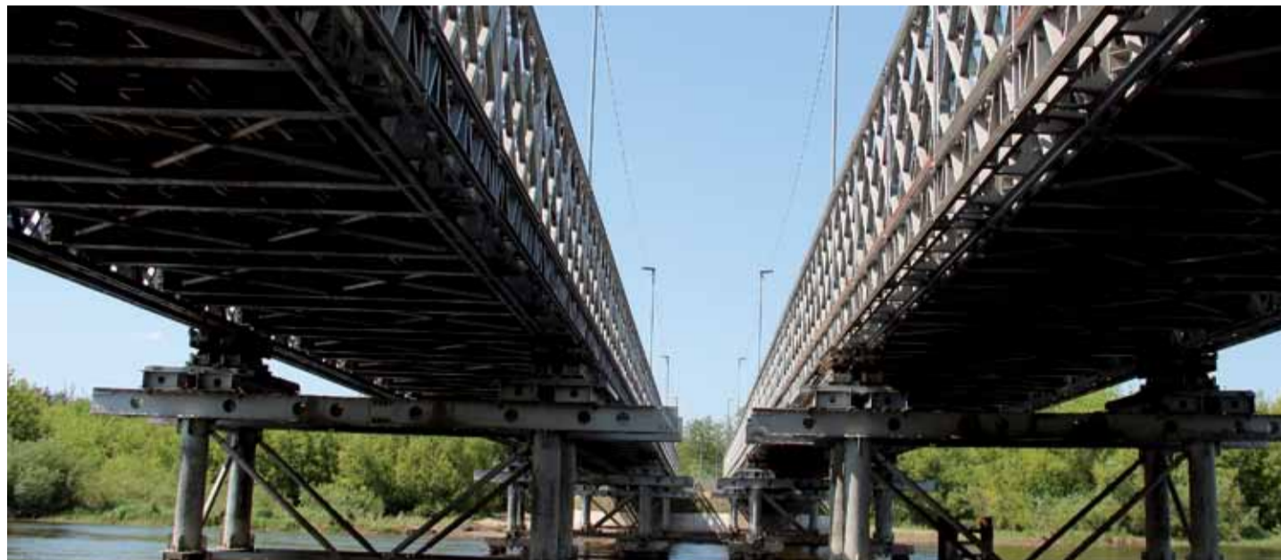
Konstrukcja DMS 65 zmontowana przez 2. Pułk Inżynierijny z Inowrocławia
