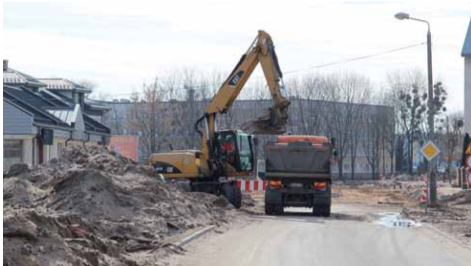
Budowa ulicy Dobrzańskiego
