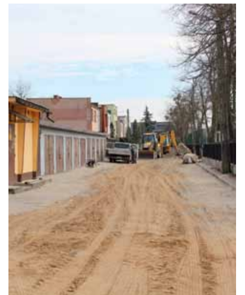
Budowa ulicy Kosynierów
