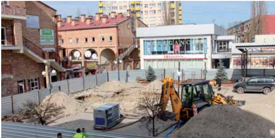
Budowa fontanny przy Domu Handlowym Kupiec
