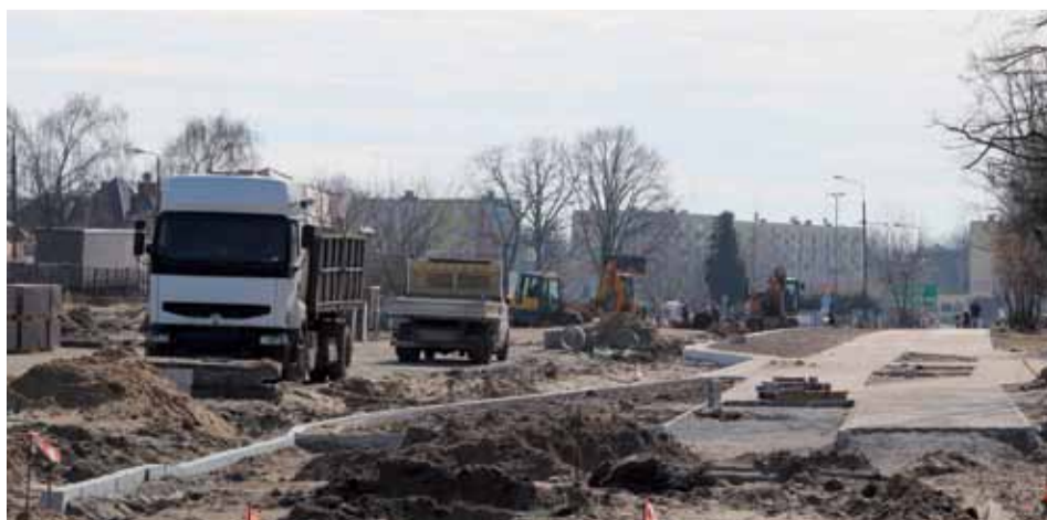
Remont ulicy Witosa
