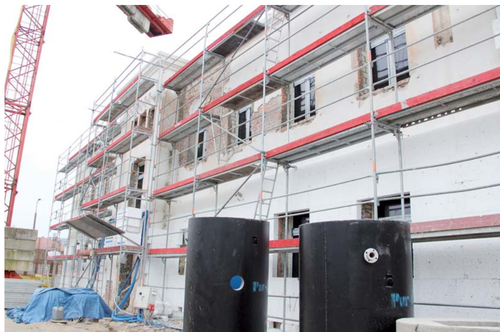
Prace przy budowie muzeum postępują zgodnie z planem
