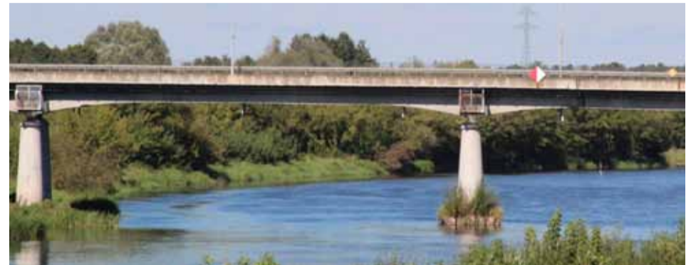
Stary most już niebawem zostanie gruntownie wyremontowany
