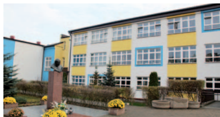
Wyremontowana SP nr 10
