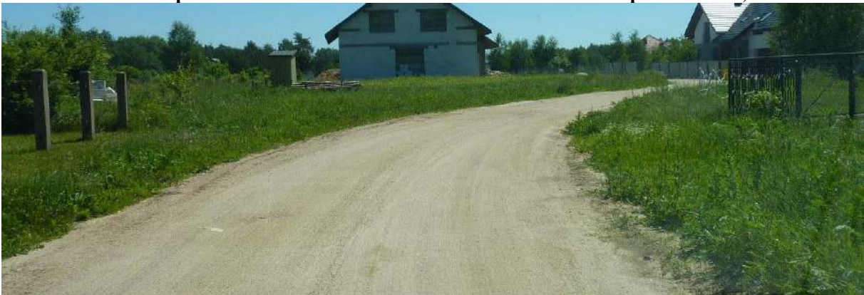
Ulica Owsiana po zleceniu WD.7021.3.4.2019 z dnia 06.05.2019 r.- profilowanie, żwir 20t
