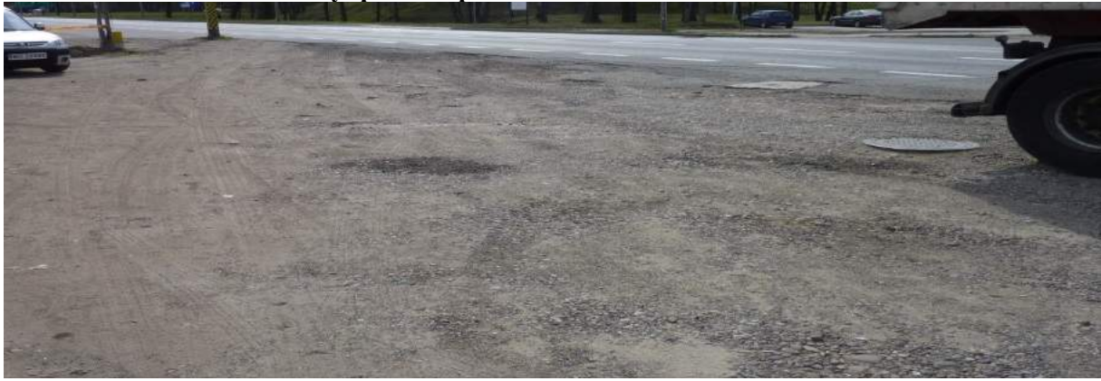
Ulica Stacha Konwy- pobocze po zleceniu WD.7021.3.3.2019 z dnia 15.04.2019 r. - profilowanie, żwir 20t
