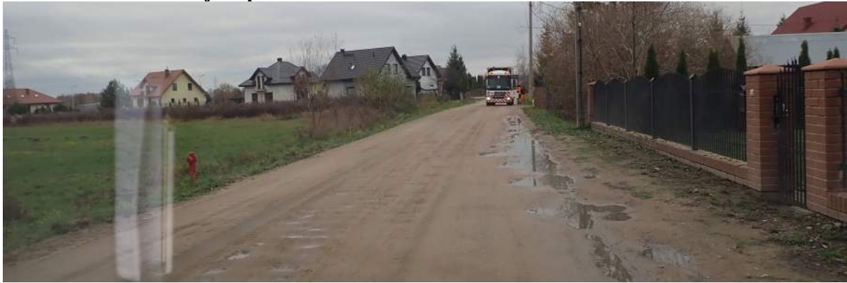
Ulica Wiejska przed zleceniem WID.7021.3.9.2019 z dnia 22.11.2019 r.
