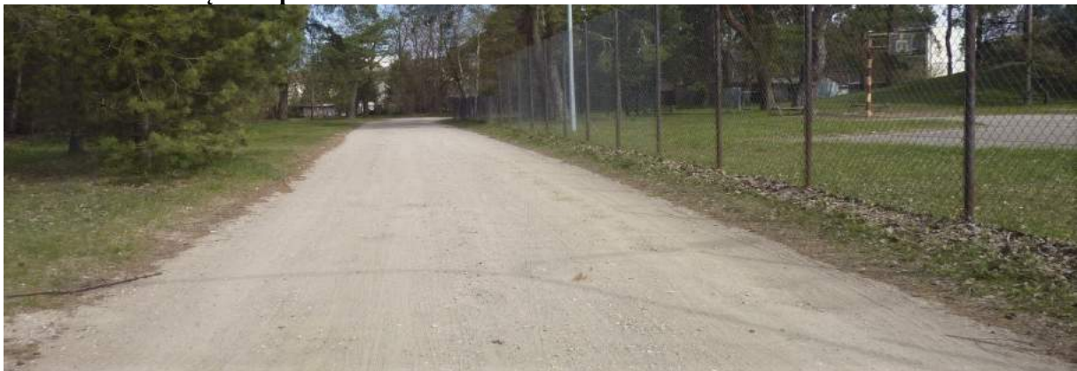
Łącznik po zleceniu WD.7021.3.4.2019 z dnia 06.05.2019 r. - profilowanie, żwir 20t
