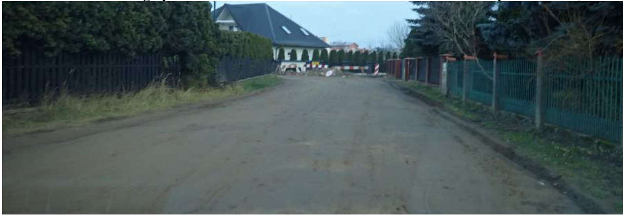
Ulica Konarskiego po zleceniu WID.7021.3.9.2019 z dnia 22.11.2019 r. - profilowanie,
