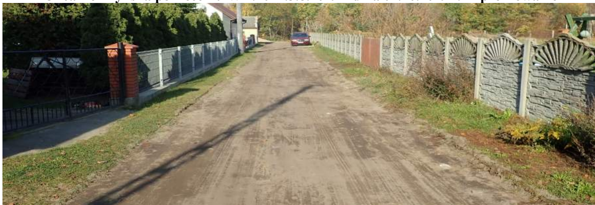
Ulica Łomżyńska po zleceniu WD.7021.3.8.2019 z dnia 07.10.2019 r. - profilowanie
