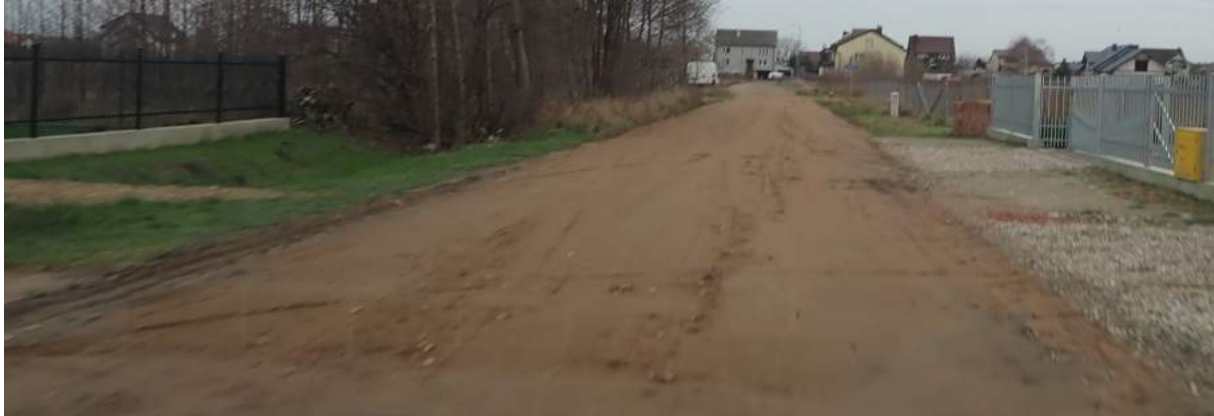
Ulica Księżnej Dobrawy po zleceniu WID.7021.3.9.2019 z dnia 22.11.2019 r. - profilowanie, żwir 10t.
