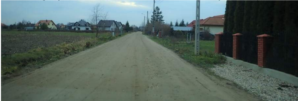
Ulica Wiejska po zleceniu WID.7021.3.9.2019 z dnia 22.11.2019 r. - profilowanie, żwir 20t
