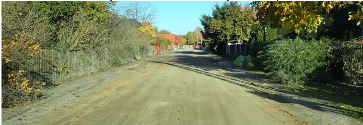
Ulica Nadziei po zleceniu e-mail 15.10.2019 - profilowanie pobocza
