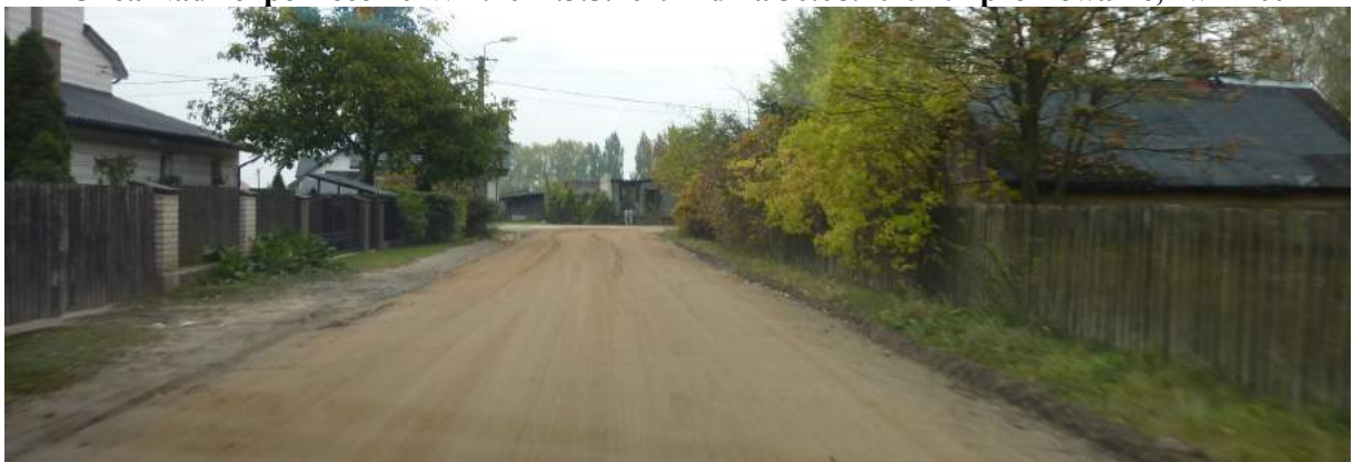
Ulica Nadziei po zleceniu WD.7021.3.5.2019 z dnia 30.08.2019 r. - profilowanie, żwir 20t
