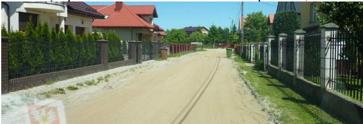
Ulica Syski po zleceniu WD.7021.3.4.2019 z dnia 06.05.2019 r.- profilowanie, żwir 20t
