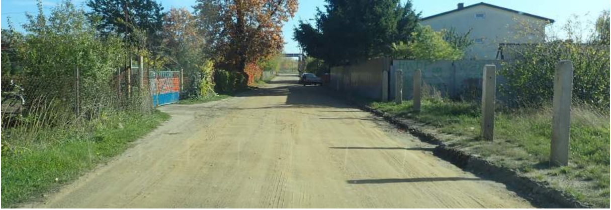
Ulica 5 Pułku Ułanów po zleceniu WD.7021.3.5.2019 z dnia 30.08.2019 r. - profilowanie, żwir 10t
