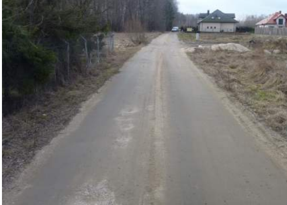
Ulica Sendlerowej po zleceniu WD.7021.3.2.2019 z dnia 19.03.2019 r. - profilowanie, gruz 40t, żwir 80t
