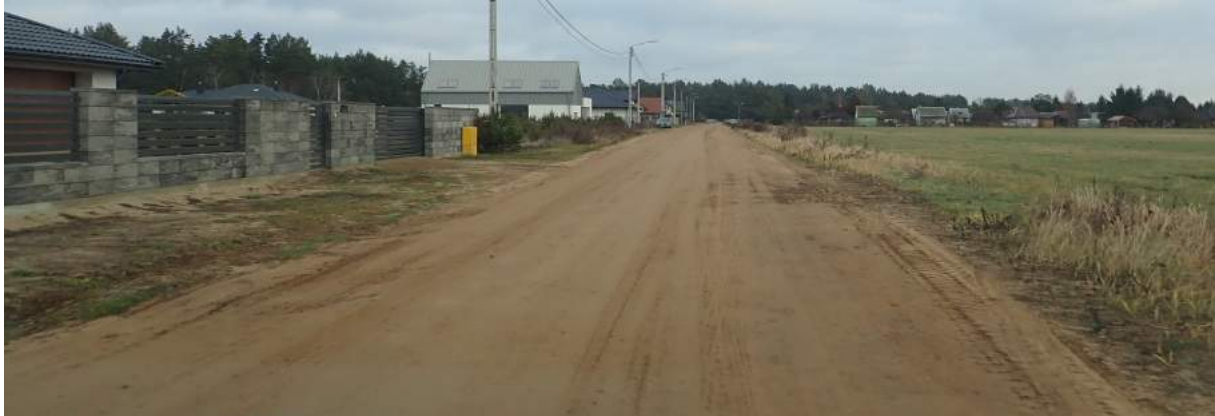
Ulica ks. Stanisława Brzóska po zleceniu WID.7021.3.9.2019 z dnia 22.11.2019 r. - profilowanie
