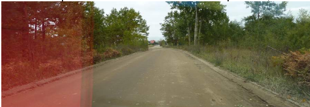
Ulica Żniwna po zleceniu WD.7021.3.5.2019 z dnia 30.08.2019 r. - profilowanie, żwir 20t
