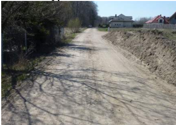
Ulica Sendlerowej po zleceniu WD.7021.3.2.2019 z dnia 19.03.2019 r. - profilowanie, gruz 40t, żwir 80t
