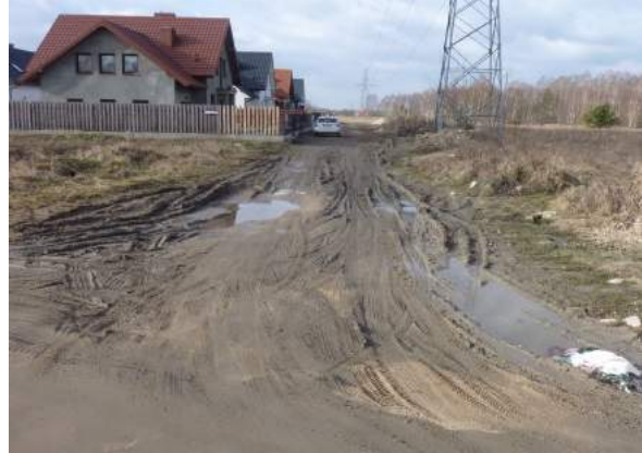
Ulica Sendlerowej po zleceniu WD.7021.3.2.2019 z dnia 19.03.2019 r. - profilowanie, gruz 40t, żwir 80t
