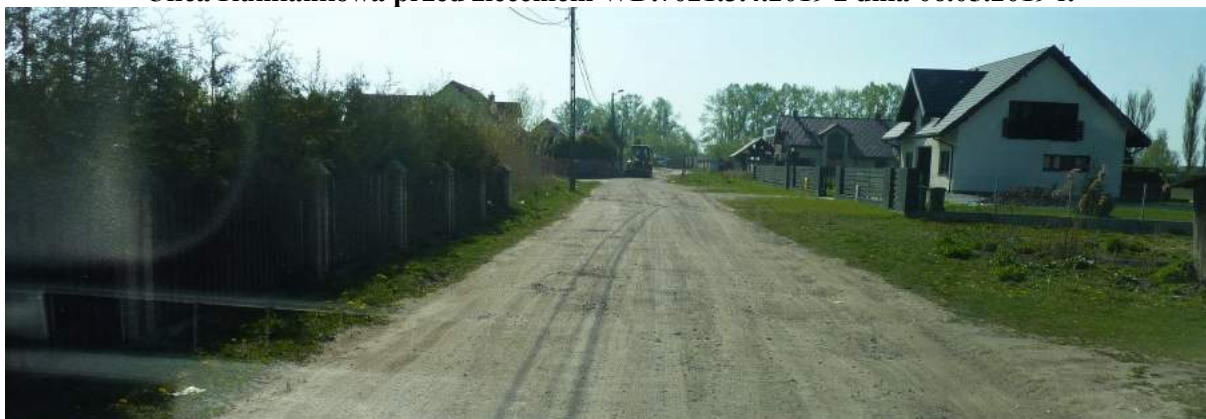
Ulica Rumiankowa po zleceniu WD.7021.3.4.2019 z dnia 06.05.2019 r.- profilowanie, żwir 40t
