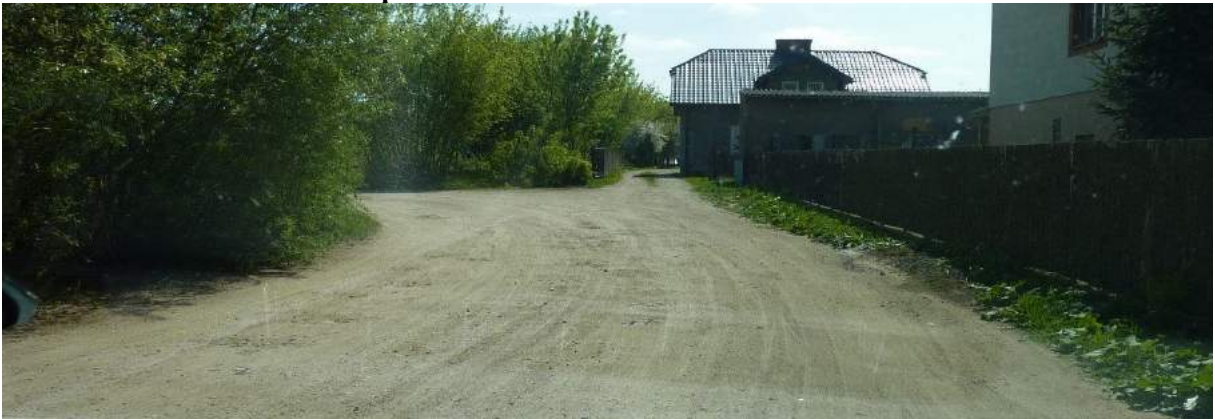
Ulica Tatarakowa po zleceniu WD.7021.3.4.2019 z dnia 06.05.2019 r.- profilowanie, żwir 20t
