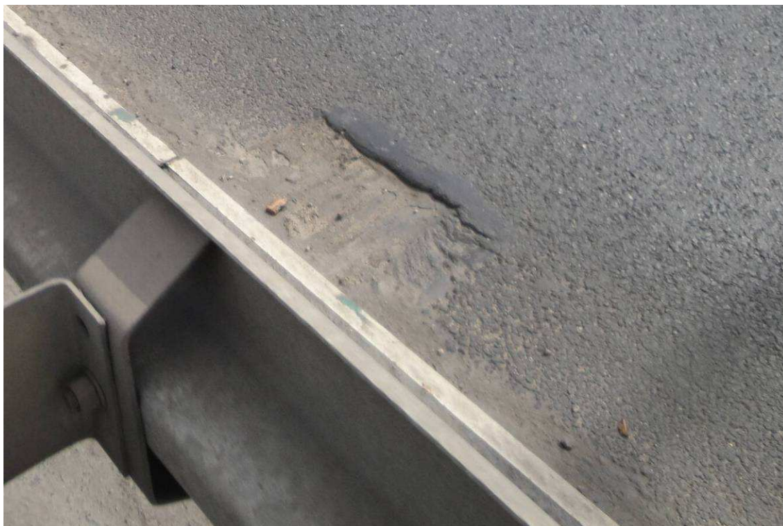
Fot. 17. Niedrożny wpust odwodnieniowy.
