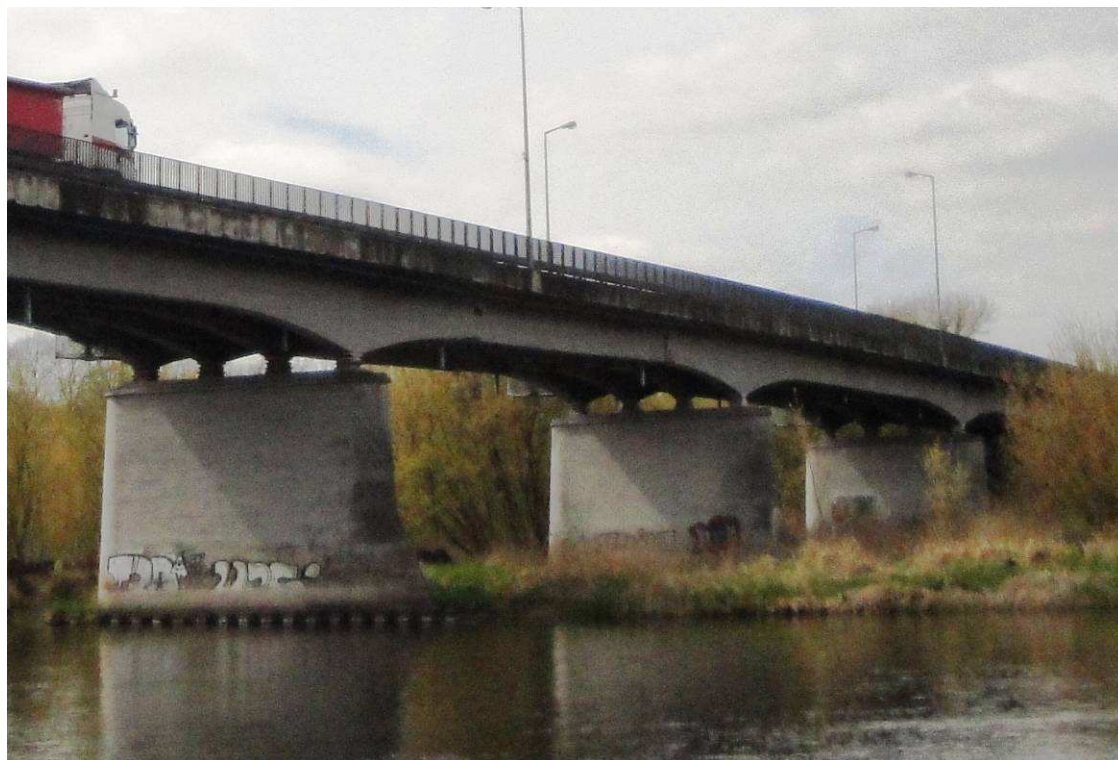
Fot. 7. Prawobrzeżne podpory zalewowe.
