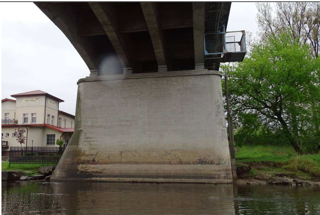
Fot. 36. Podpora 3. Praktycznie bez uszkodzeń.
