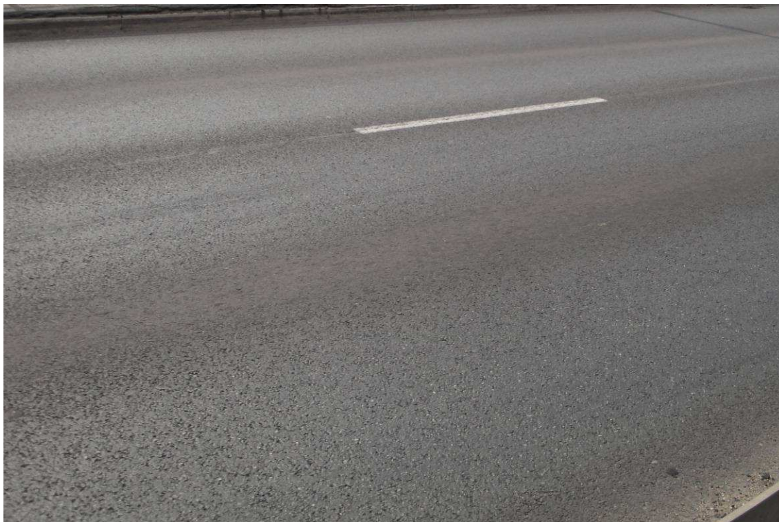
Fot. 9. Nawierzchnia jezdni na obiekcie. Stan dobry po remoncie w roku 2014.
