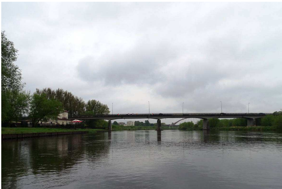
Fot. 1. Widok z boku od strony górnej wody.
