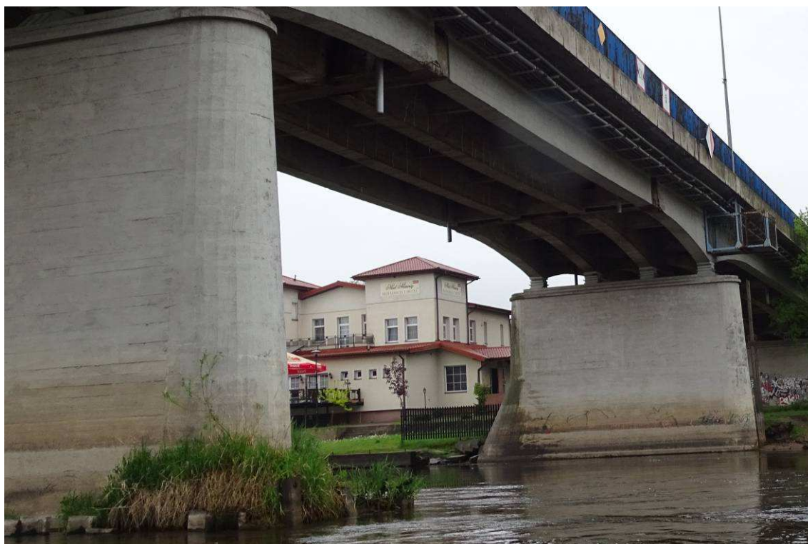
Fot. 8. Widok ogólny podpór pośrednich.
