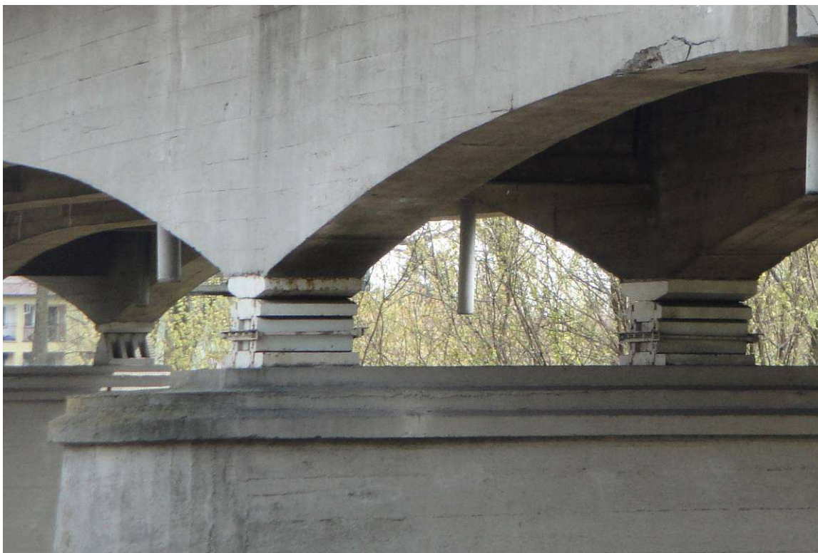
Fot. 37. Podpora 7. Praktycznie bez uszkodzeń.
