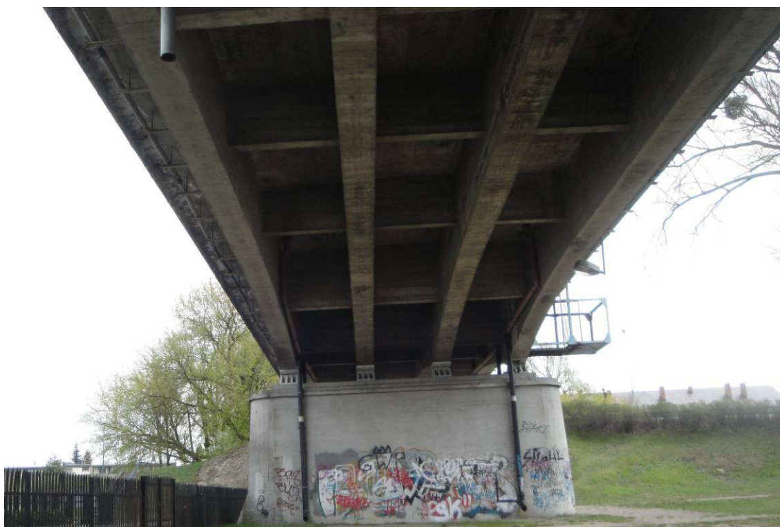
Fot. 5. Widok spodu konstrukcji w przęśle 2-3.
