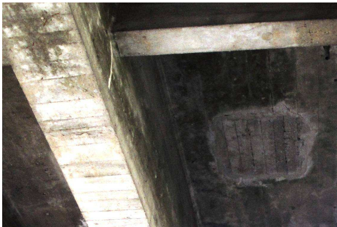
Fot. 25. Wegetacja alg na spodzie płyty, świadcząca o zubożeniu otuliny. Ślady napraw spodu płyty.
