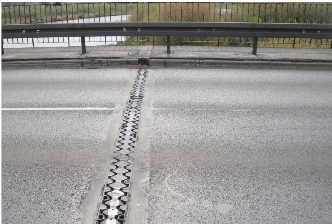
Fot. 13. Wypełnienie asfaltem lanym wokół urządzeń dylatacyjnych. Uszkodzone nakładki wyciszające.
