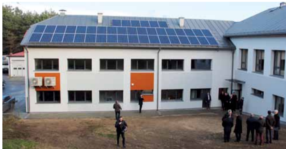
Instalacja fotowoltaiczna zasila siedzibę OPWiK
