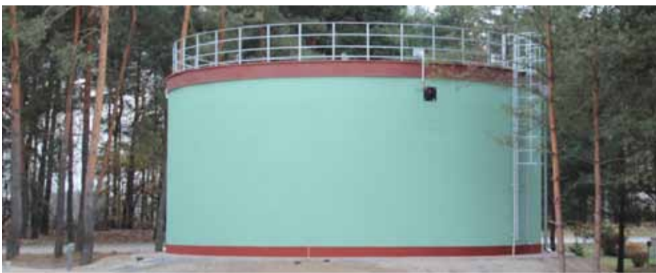
Zbiornik wody pitnej w OPWiK
