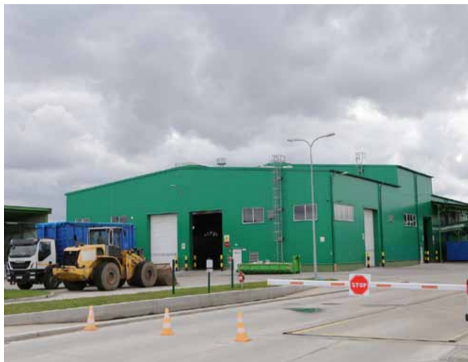
Największa inwestycja w historii OTBS to Stacja Segregacji Odpadów Komunalnych
