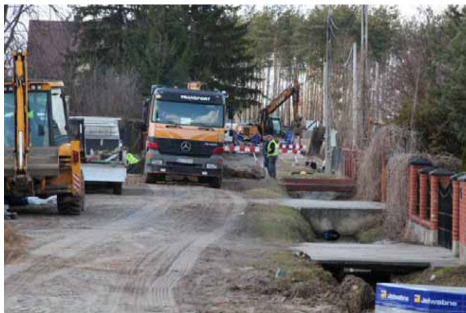
Pomimo niesprzyjającej pogody trwają prace na ulicy Ordona
