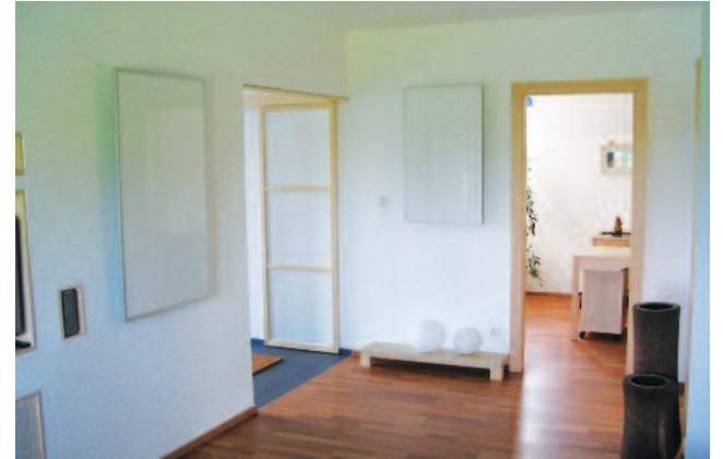
Niektóre ze sposobów montażu paneli grzewczych
