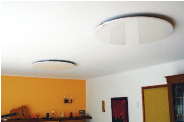
Niektóre ze sposobów montażu paneli grzewczych
